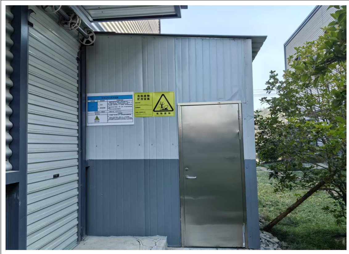
图 9-1 本项目危废暂存库
