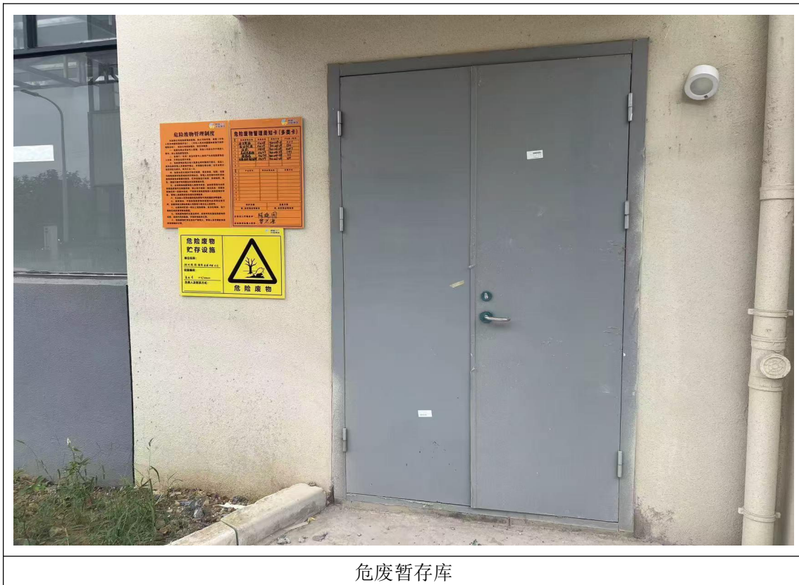
图 8-1 本项目危废暂存库
