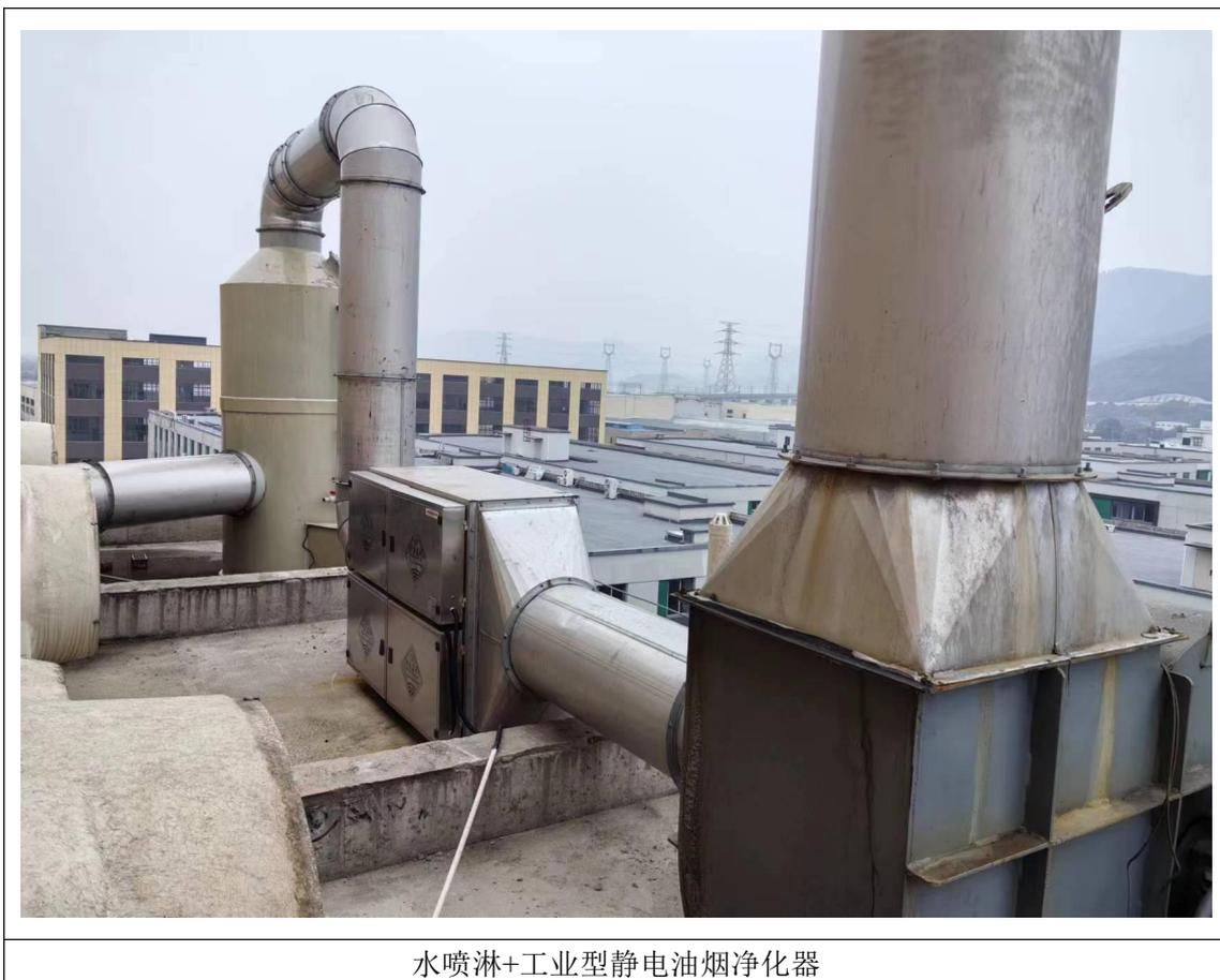
图 4-4 本项目废气处理设施照片
