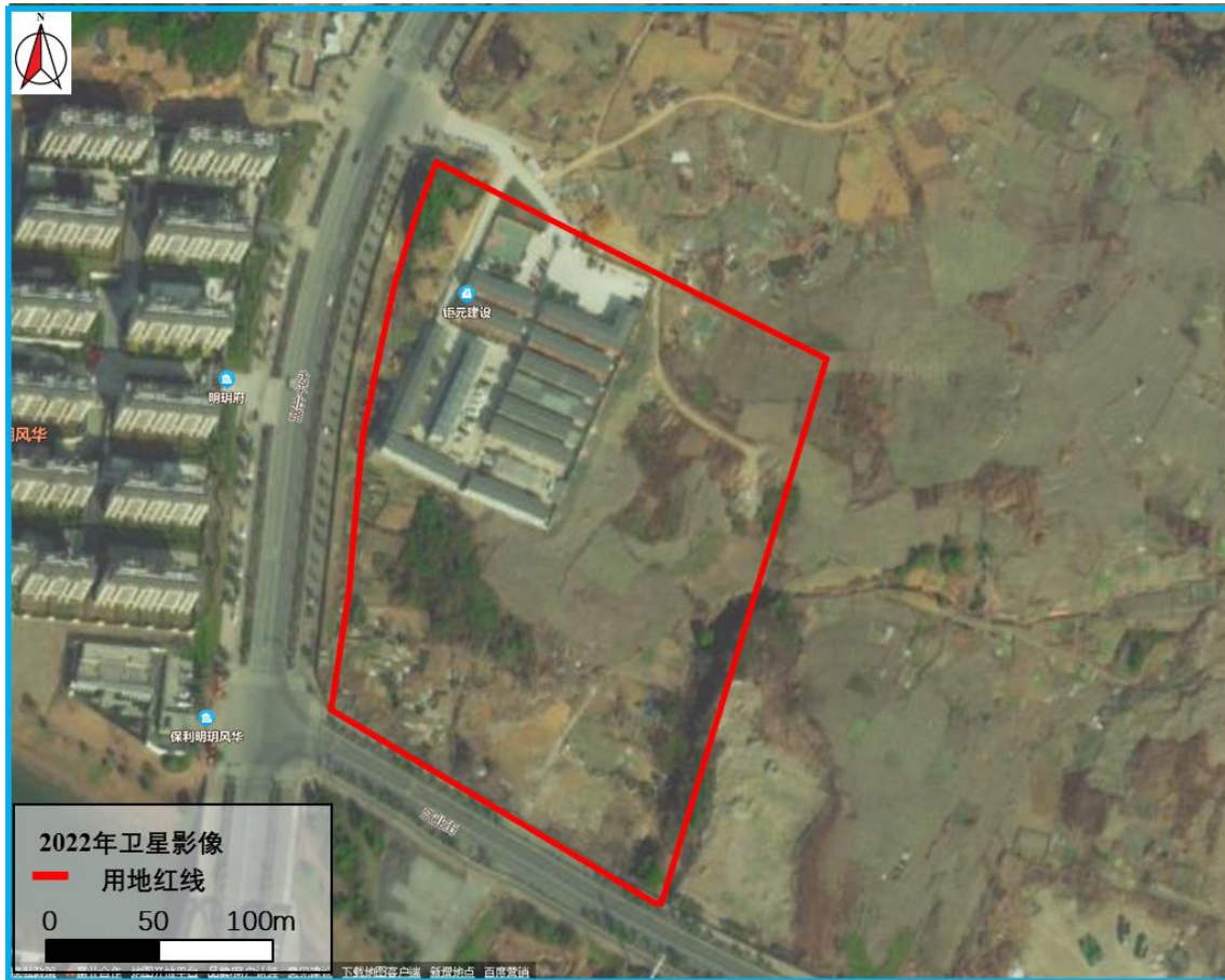
图 5-2 德清县阜溪街道（2021）109 号地块最新卫星影像图
