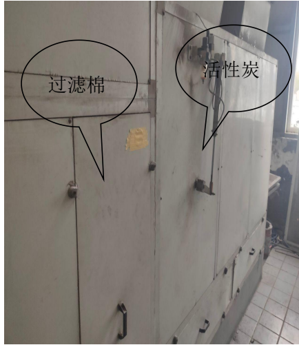
油漆废气处理设施
