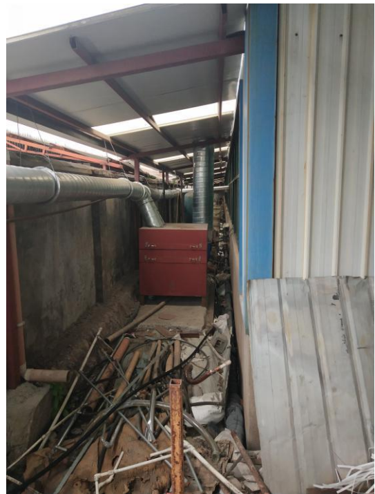
2#厂房废气处理设施（活性炭）
