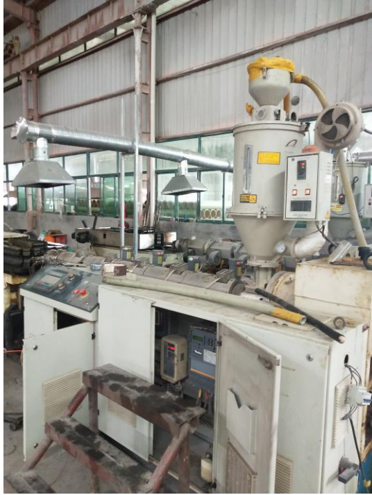
废气收集装置
