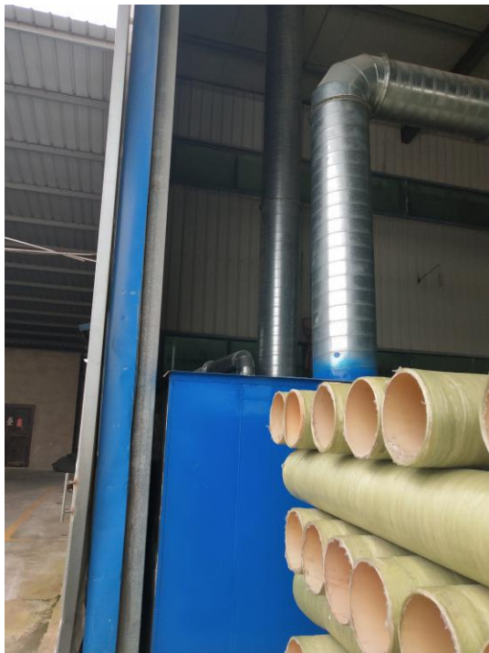
1#厂房废气处理设施（活性炭）
